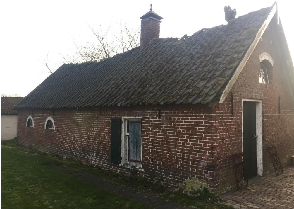
Linker zijgevel bestaand bakhuisje
