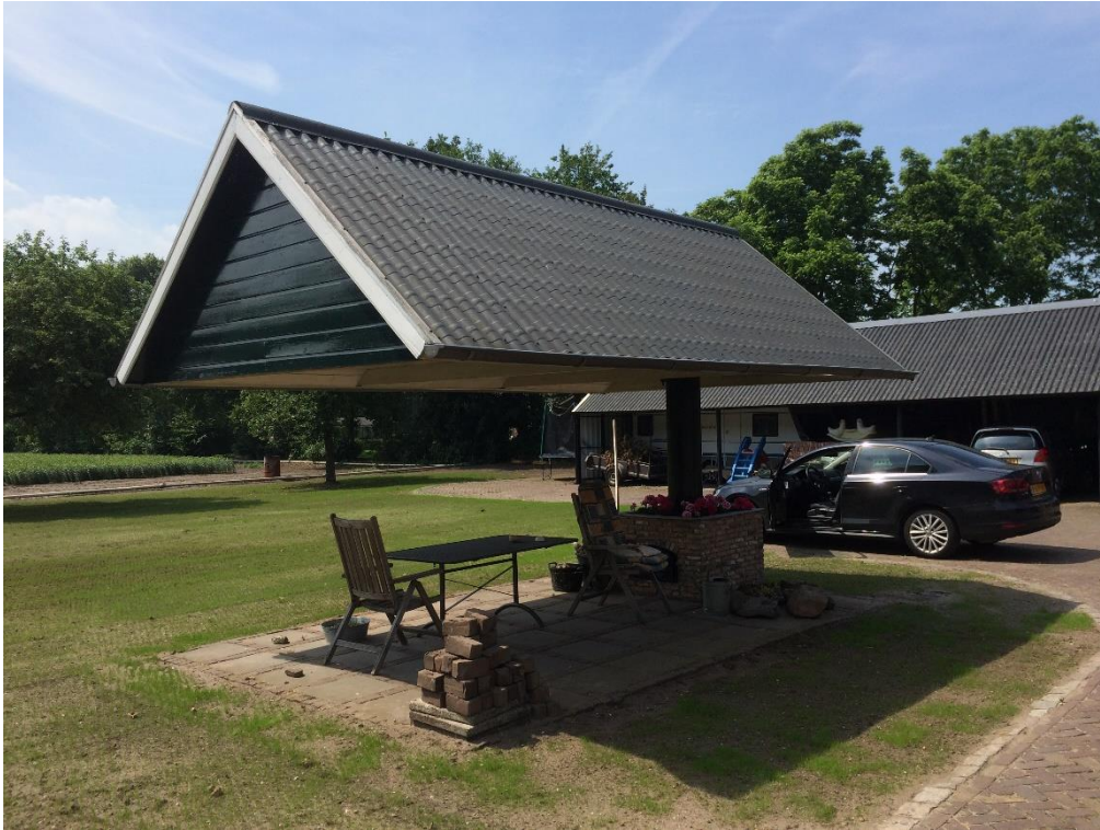
Bouwwerk, geen gebouw zijnde zoals bovenstaand aangeduid met cijfer 3
