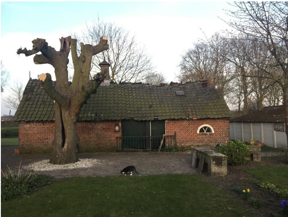
Bakhuisje zoals bovenstaand aangeduid met cijfer 4
