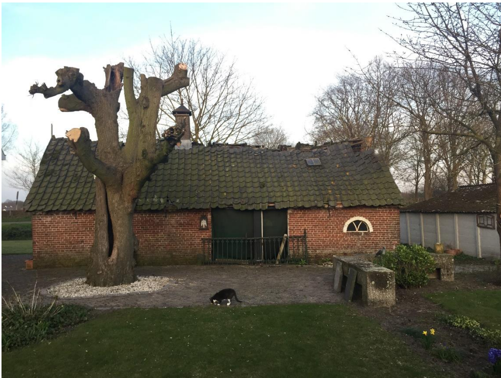
Rechter zijgevel bestaand bakhuisje
