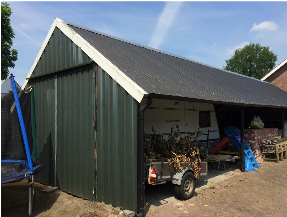
Overkapping zoals bovenstaand aangeduid met cijfer 2
