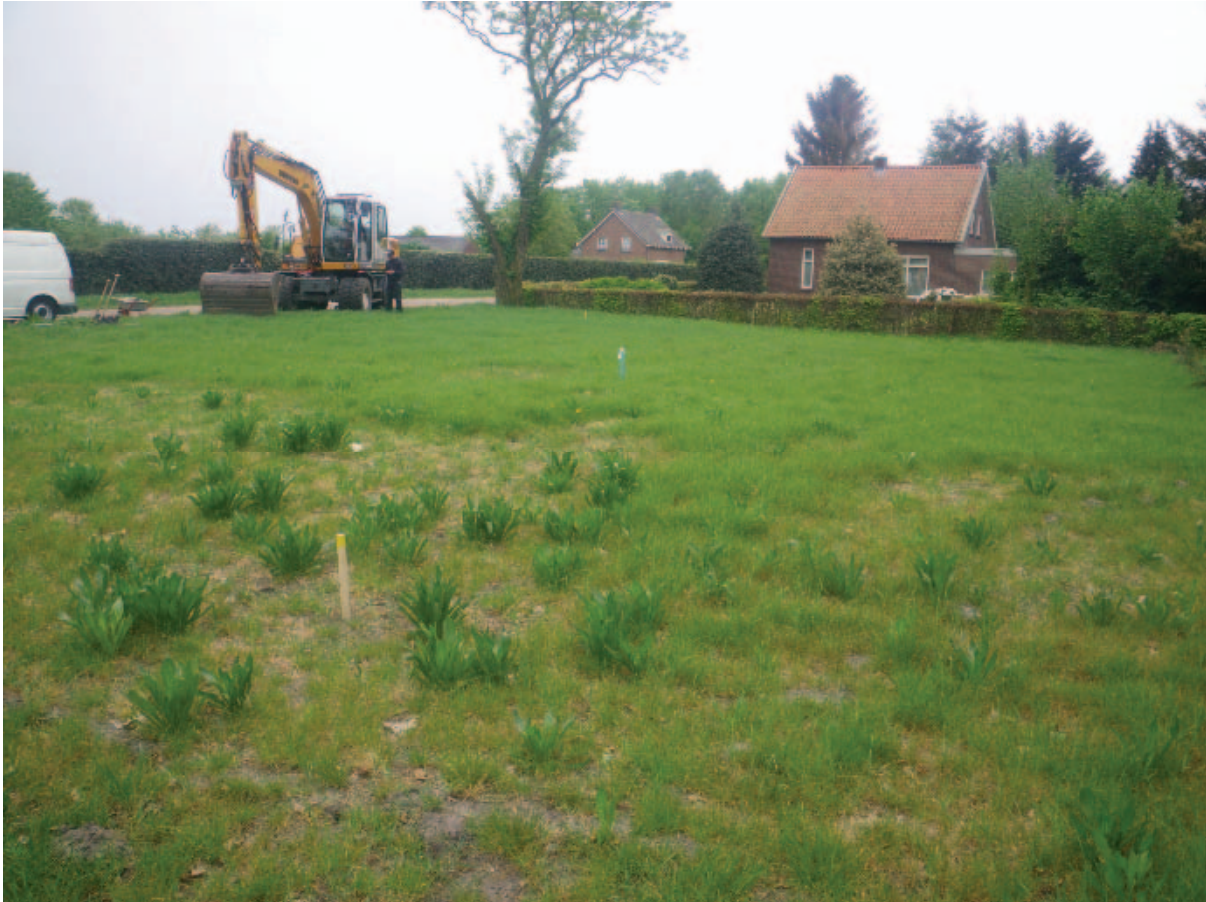
Fig. 1: Het plangebied voor aanvang van de werkzaamheden vanuit het noordwesten.
