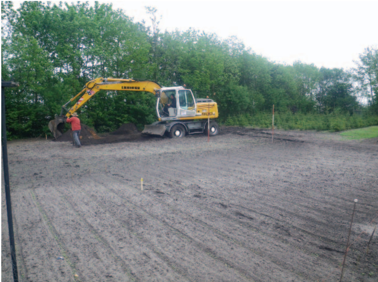
Fig. 1: Het plangebied voor aanvang van de werkzaamheden vanuit het zuiden.
