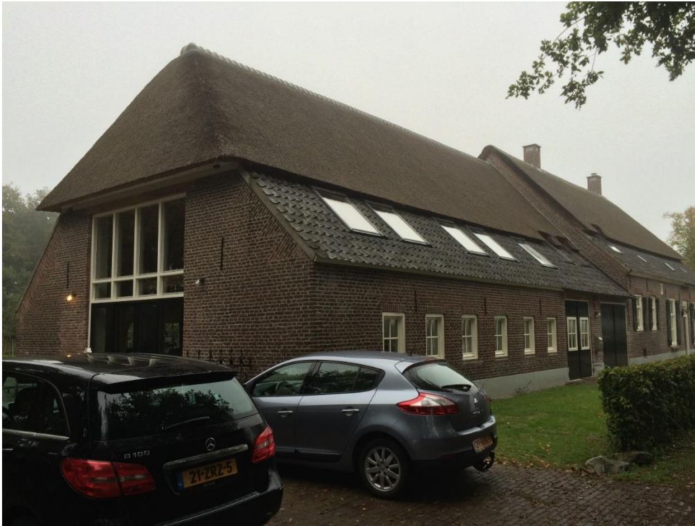
Linker zijgevel bestaande woning
