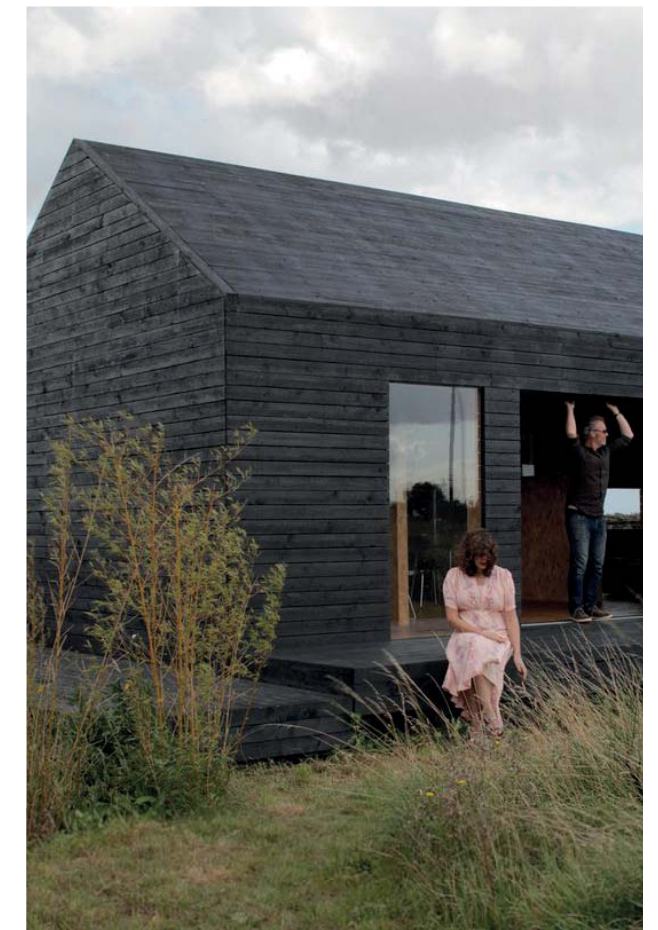
verkoalde houten gevelbeplanking
