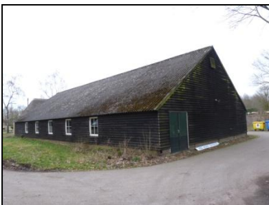
Figuur 6. Kantoor en grote zaal.
