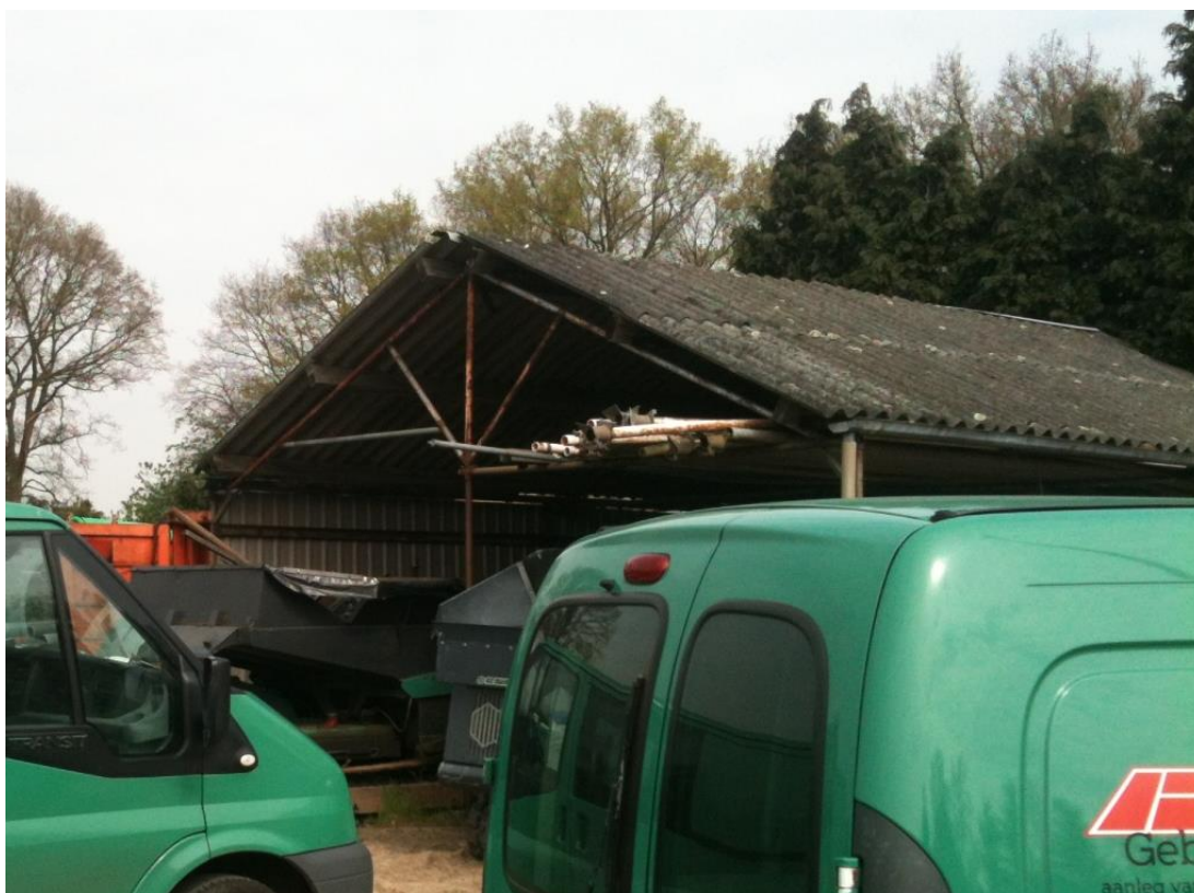
Bestaande verouderde opstal op het perceel Rijksweg 13
