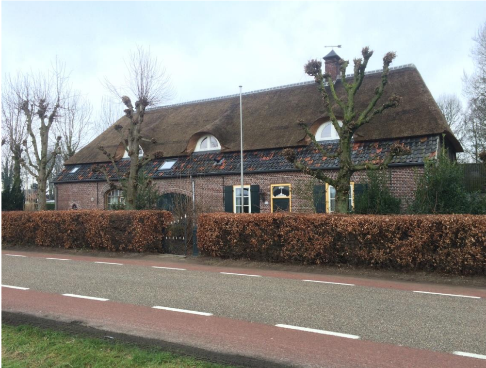
Vooraanzicht bestaande woning
