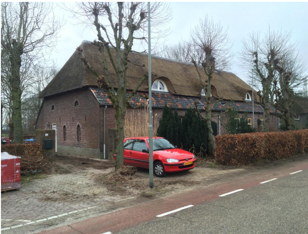
Linker zijgevel bestaande woning
