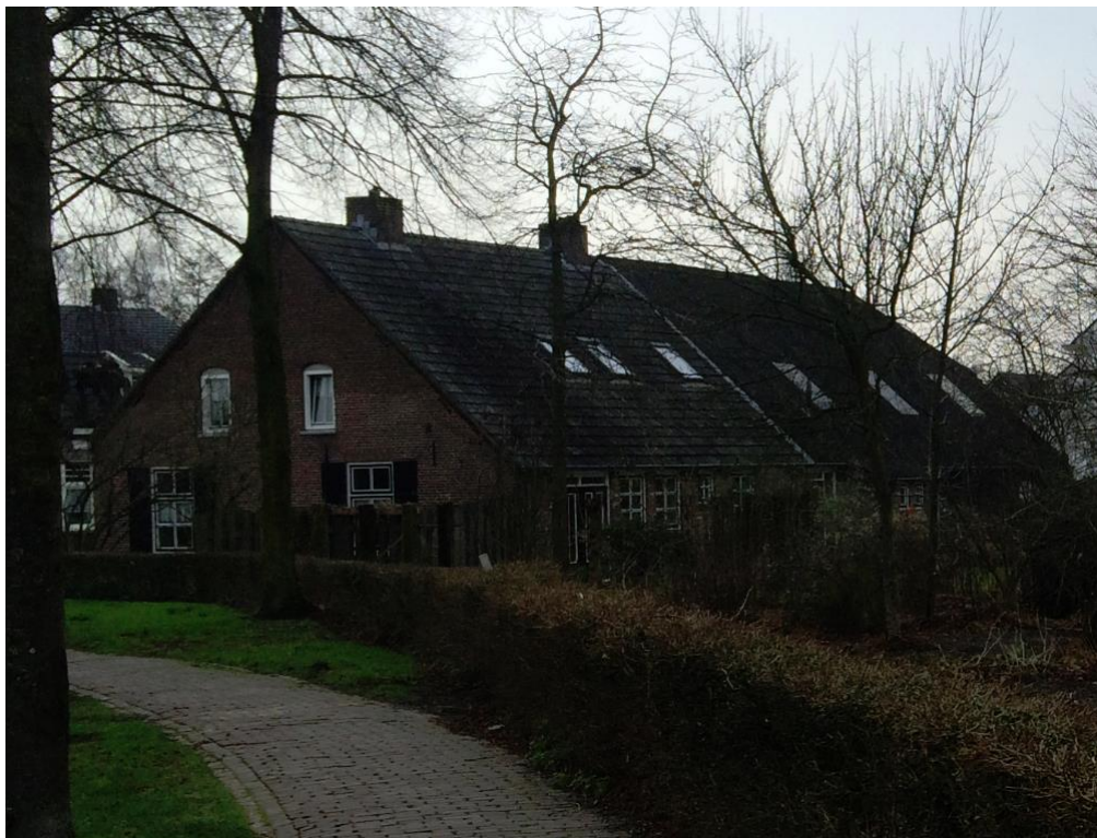
Bestaande burgerwoning Kerkstraat 112
