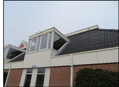
Figuur 17. Groot aantal dakranden geschikt voor gebouwbewonende vleermuizen (sporthal)
