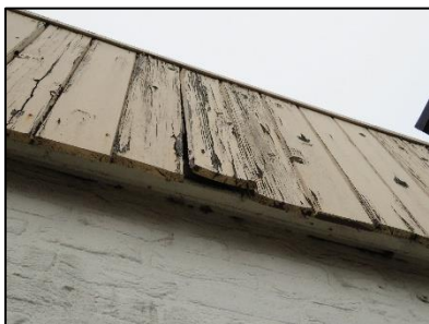
Figuur 18. Loszittende betimmering (horeca)
