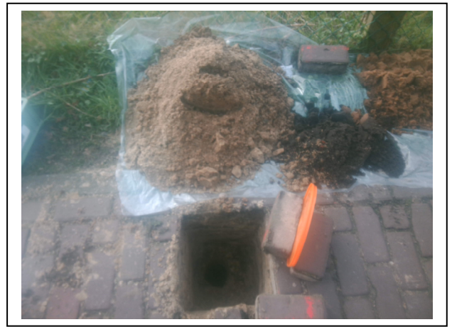
Foto 14. Asbestinspectiegat 14
