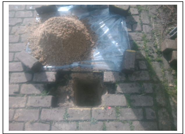
Foto 22. Asbestinspectiegat 22
