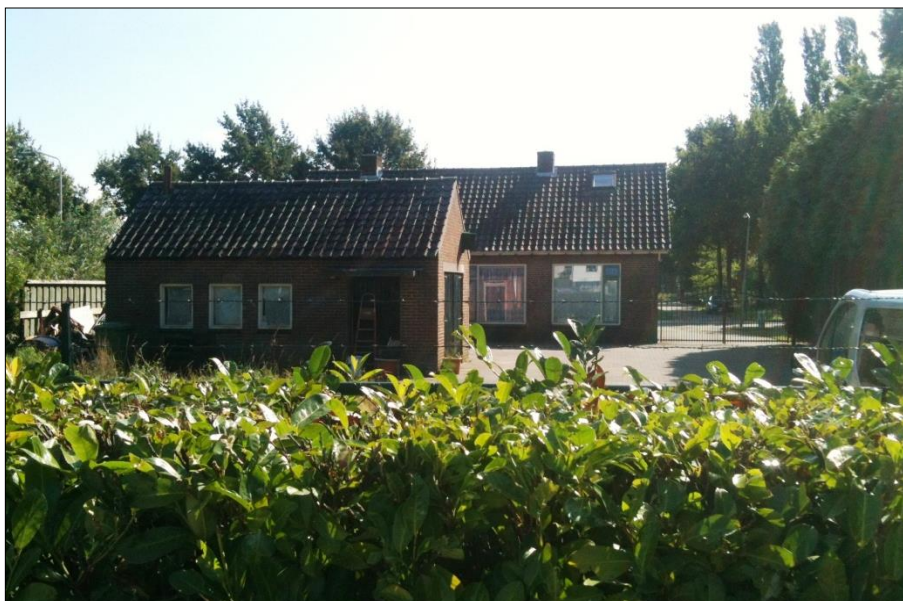
Achteraanzicht bestaande woning met bijgebouw genomen vanaf de parkeerplaats van Peters Projectontwikkeling Schaijk B.V aan de Scheltseweg
