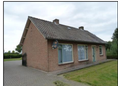
Figuur 5. Voorzijde van de woning.
