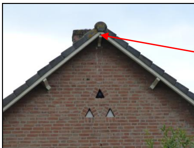
Figuur 12. Nok van het dak van de woning.
