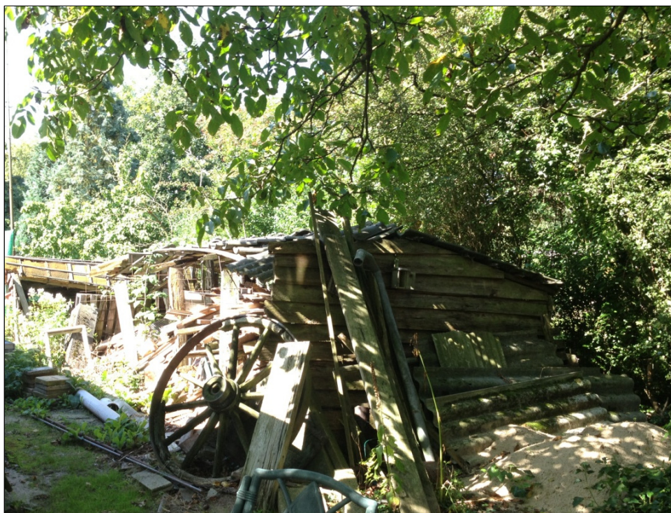
Afbeelding 7: te slopen bebouwing t.b.v. houtopslag
