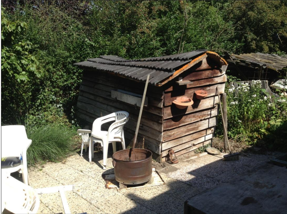
Afbeelding 6: te slopen tuinhuisje
