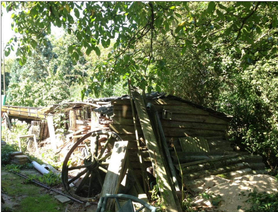
Afbeelding 7: te slopen bebouwing t.b.v. houtopslag
