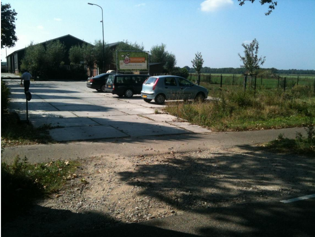
Bestaande inrit aan de Zeelandsedreef 28a te Schaijk
