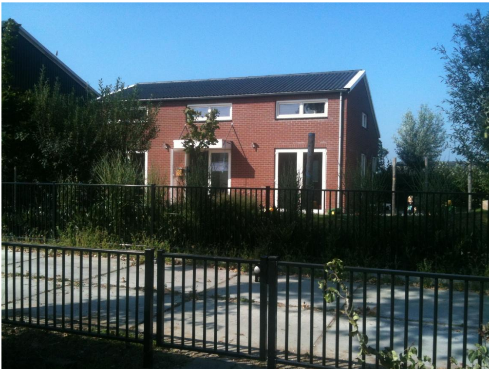
Aanzicht kinderdagverblijf Koekeloere gezien vanaf de bedrijfswoning
