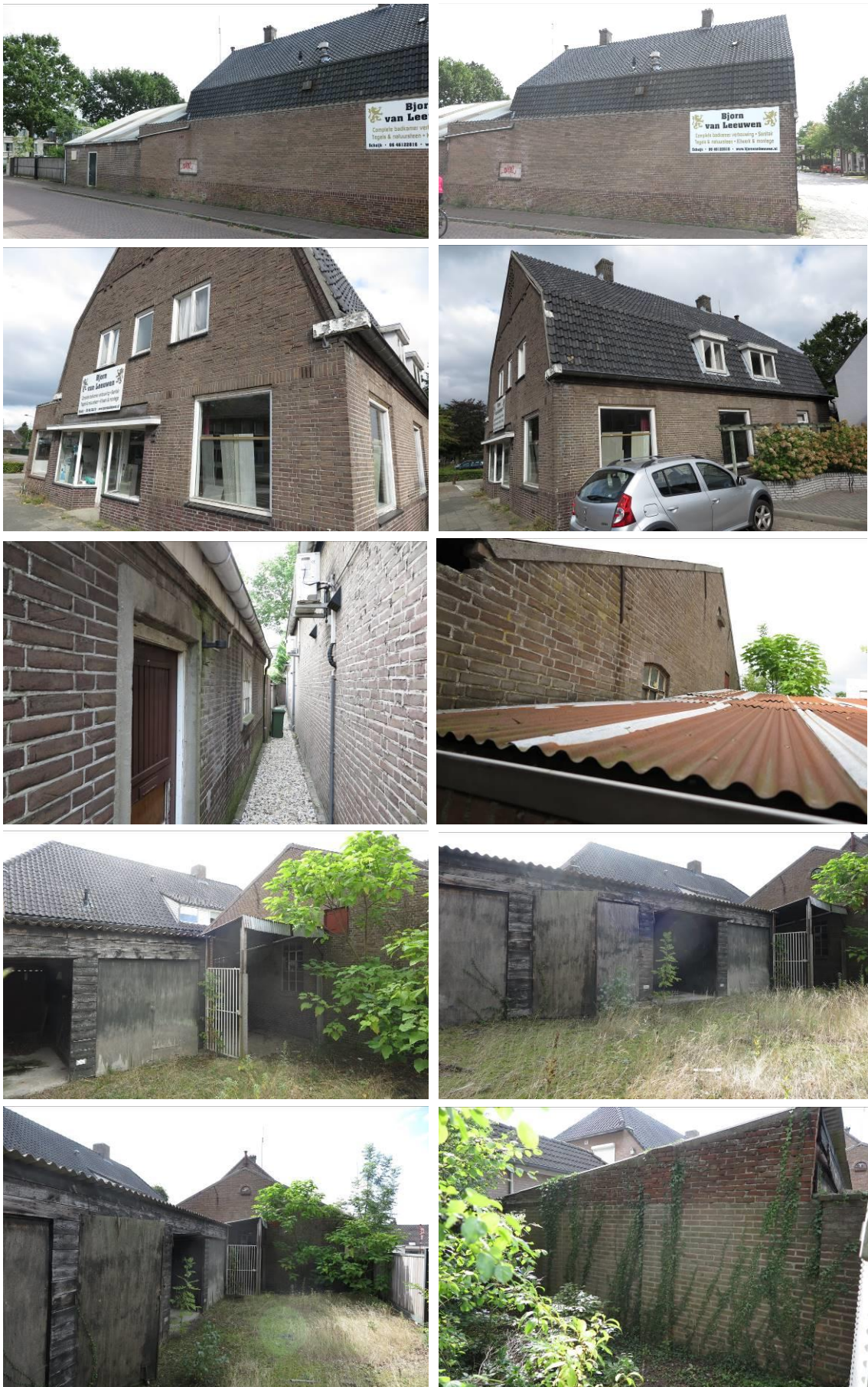
Figuur 2. Aanzicht van het plangebied aan de Runstraat 12 te Schaijk.
