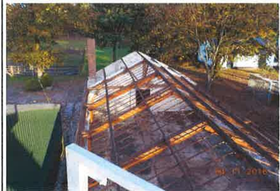
Foto 6 Overzicht foto constructiedelen schuur 8
