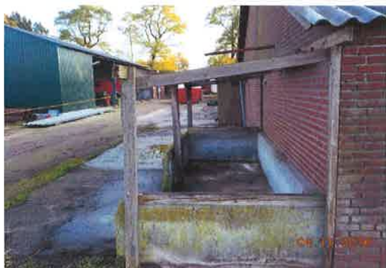
Foto 5 Overzicht foto aanbouw schuur 5
