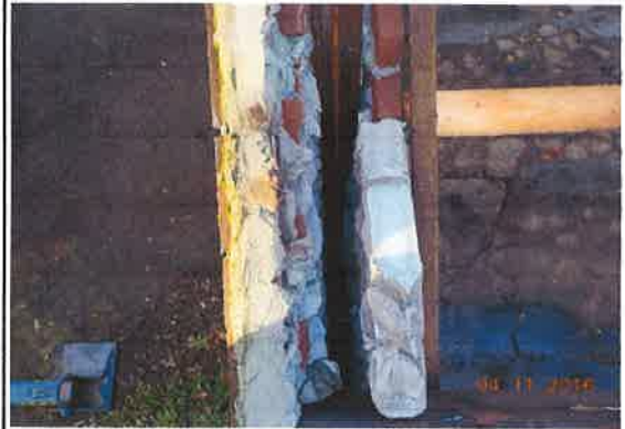
Foto 8 Detail foto spouw schuur 8
