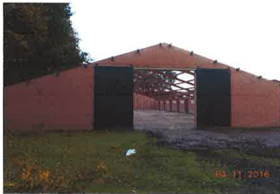
Foto 3 Overzicht foto schuur 2
