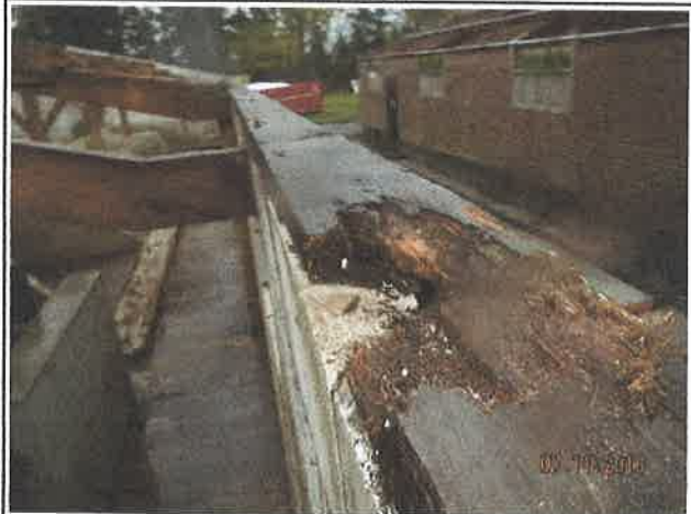
Foto 5. Linker dakvlak en muurplaat.
