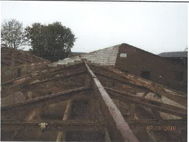
Foto 3. Nok en golfplaten en ventilatiekokers (luchtkasten) verwijderd.
