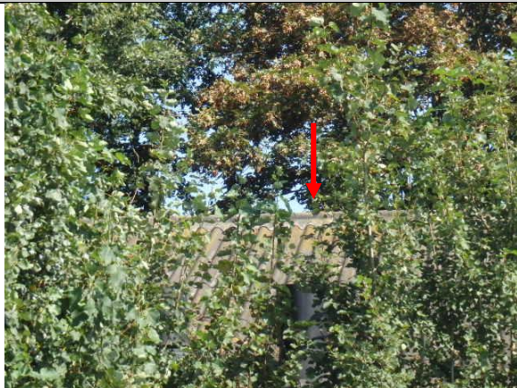
Foto nr. 12, Nokvorsten van dak schuur 5, Identiek aan M 2 asbesthoudend
