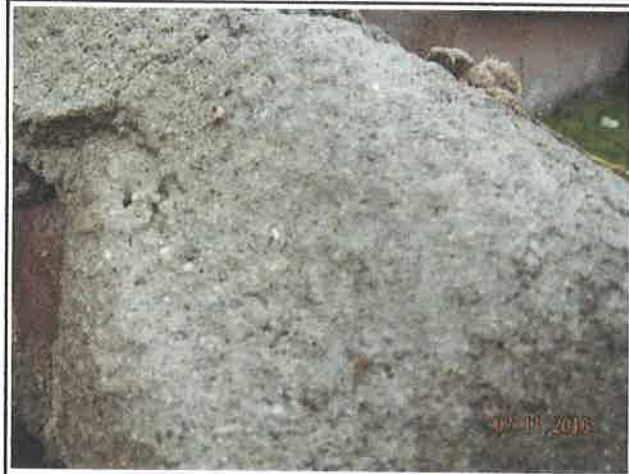
Foto 4. Wafelstructuur geïnspecteerd en niets aangetroffen.
