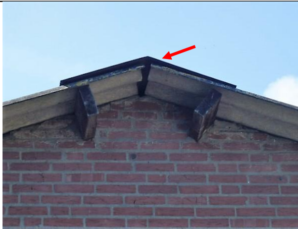
Foto nr. 3, Nokvorsten van dak schuur 2, M 2 asbesthoudend
