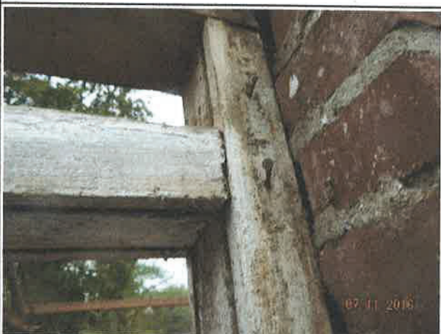
Foto 9. Aanvullende schoonmaak rondom verwijderde bronnen B5.
