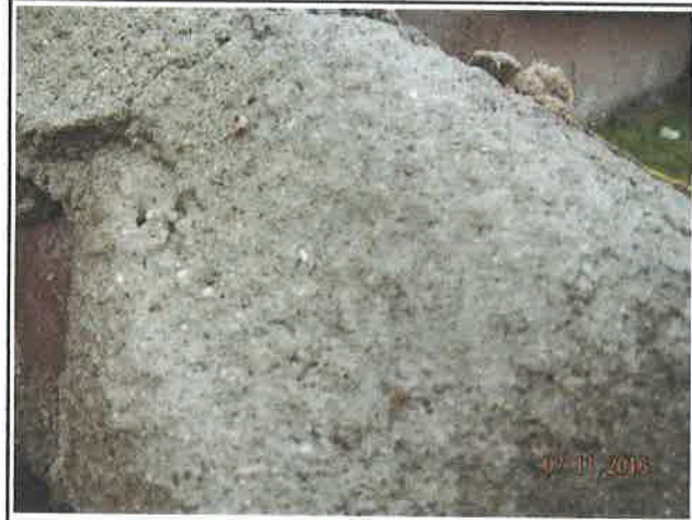
Foto 4. Wafelstructuur geinspecteerd en niets aangetroffen.
