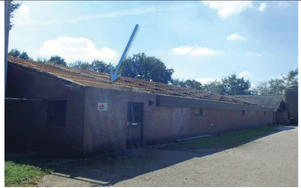
Foto nr. 17 schuur nr. 4 dak voormalig voorzien van damwand profielen, open schuur
