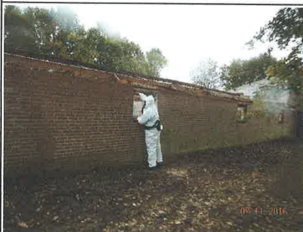
Foto 11. Aanvullende schoonmaak rondom verwijderde bron 5.
