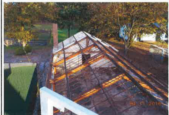
Foto 6 Overzicht foto constructiedelen schuur 8
