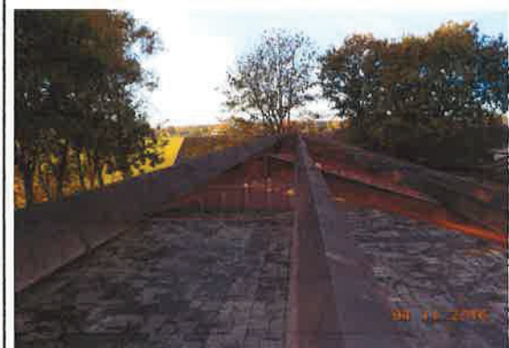
Foto 4 Detail foto constructiedelen schuur 2 en straatwerk in de schuur
