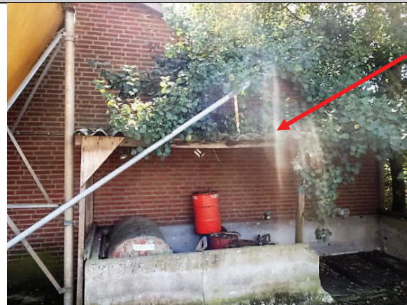
Foto nr. 13, Golfplaten dak van afgang schuur 5, Identiek aan M 1 asbesthoudend
