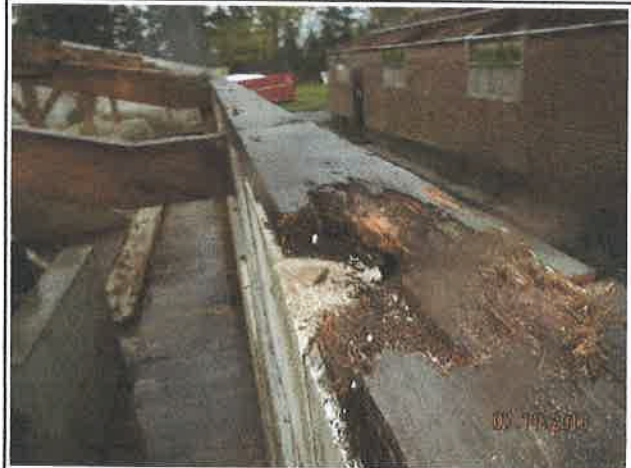
Foto 5. Linker dakvlak en muurplaat.
