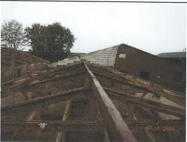
Foto 3. Nok en golfplaten en ventilatiekokers (luchtkasten) verwijderd.
