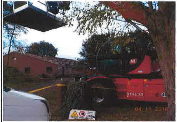
Foto 2 Overzicht foto inspectiegebied met de verreiker en schuur 4 (Asbestvrij)
