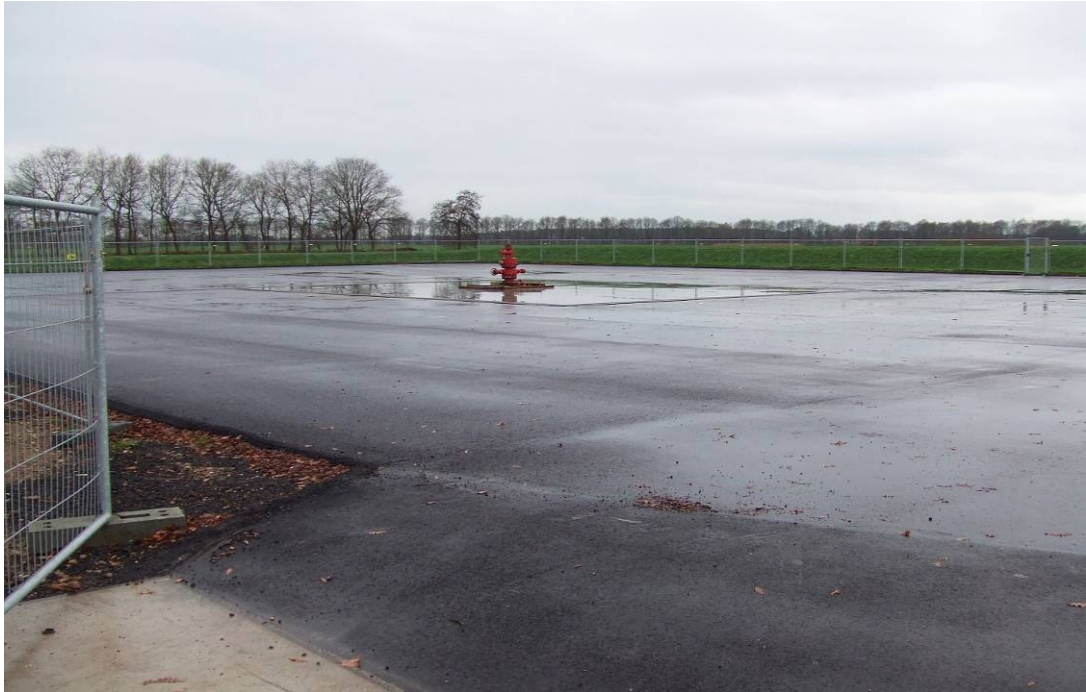
Figuur 3 Situatie locatie Vinkega met daarop zichtbaar de afsluiter (foto december 2009)
