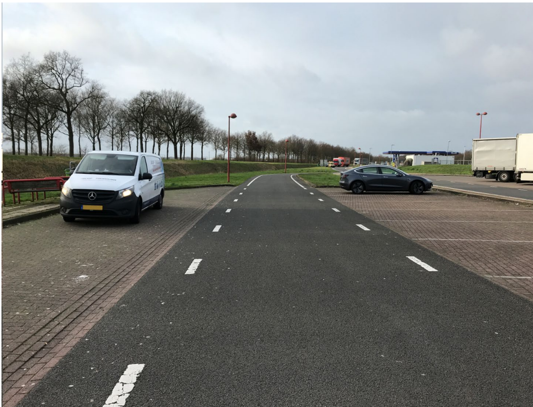
Figuur 1.3: Huidige situatie projectgebied gezien vanaf zuidoostzijde (bron: Fastned)
