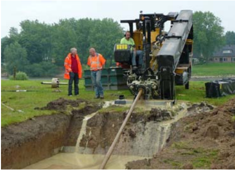
Figuur 3 Booropstelling ten behoeve van een gestuurde boring
