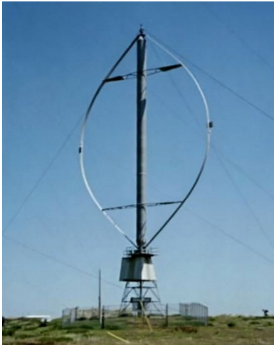
Windturbine van het zgn. 'Darrieus-type'
