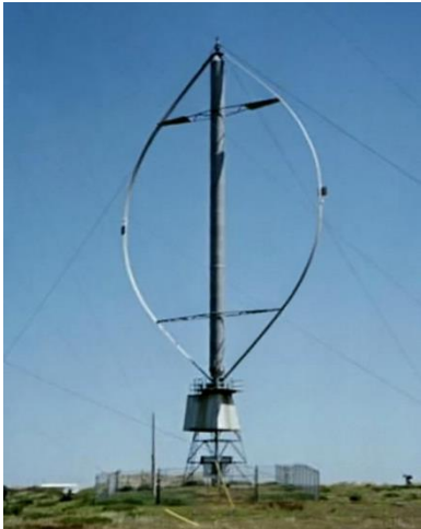
Windturbine van het zgn. 'Darrieus-type'
