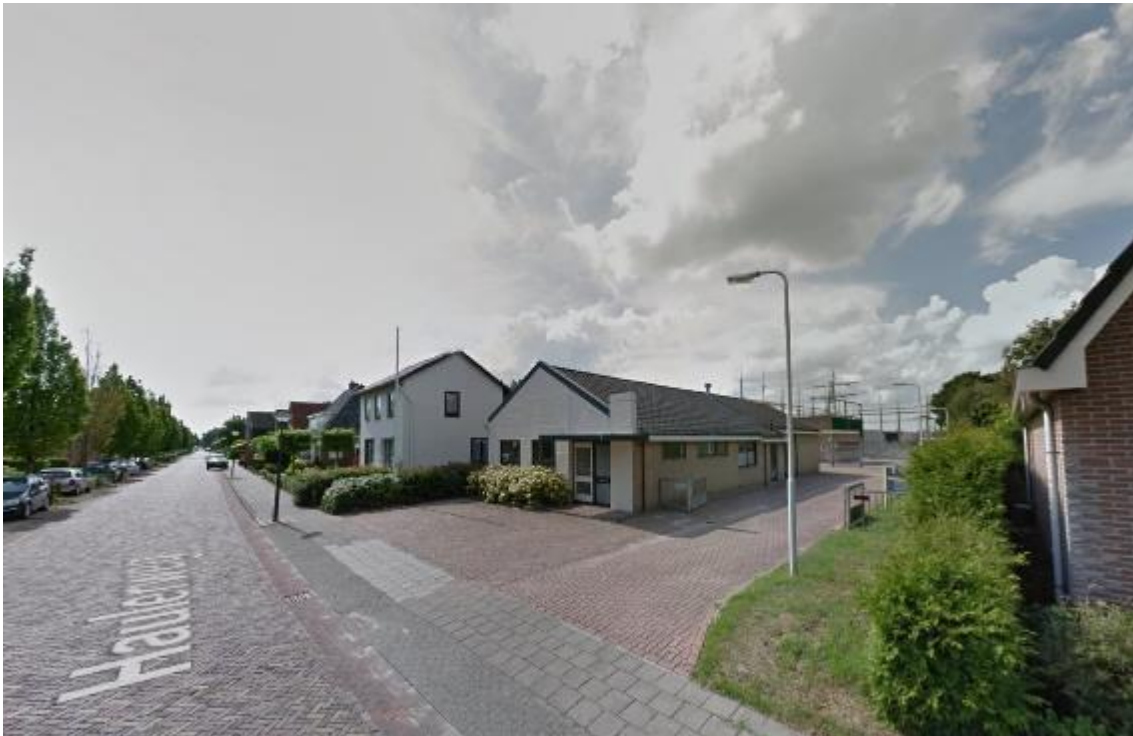
afbeelding 2.2: aanzicht aan de Haulerweg met toegang tot het terrein (het dienstgebouw vooraan is inmiddels gesloopt)
