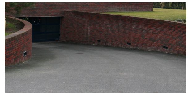
Toerit past in de park-setting (geen betonnen muurwerk)
