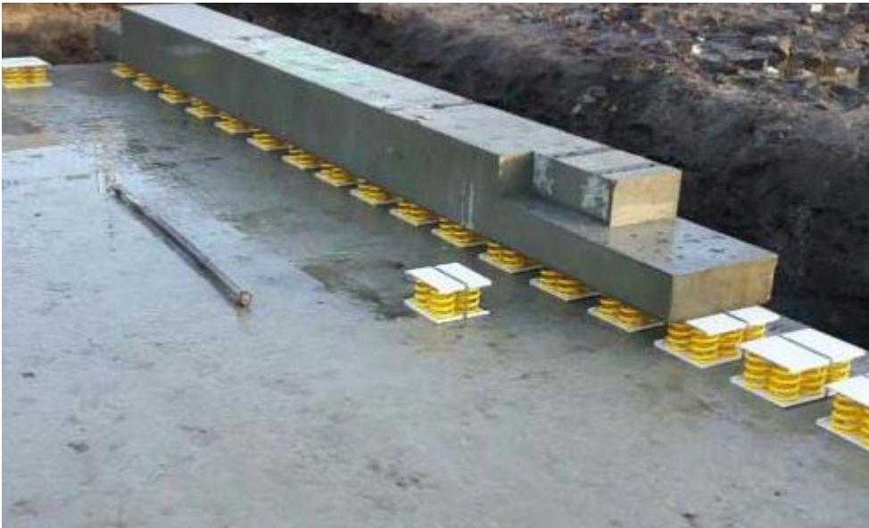
Figuur 30 Dubbele fundering met stalen veerdozen (project in Prinsenbeek)
