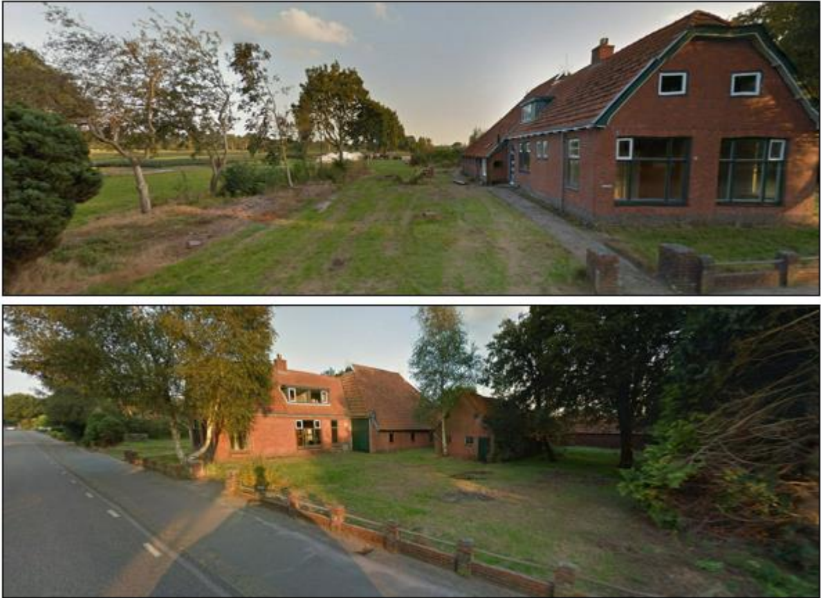
Figuur 2.2 Straatbeelden huidig erf (Bron: Google Streetview)
