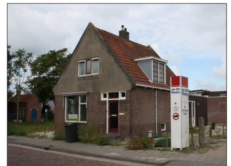
uitbreiding opvang aan de Haulerweg
