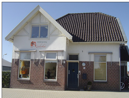
bestaande opvang aan Keiweg
