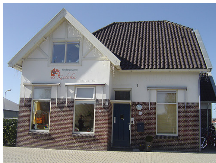
bestaande opvang aan Keiweg
