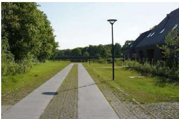
Karrenspoor met betonplaten
