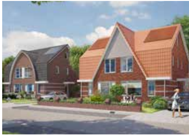
Kleur zonnepanelen afstemmen op dakbedekking
