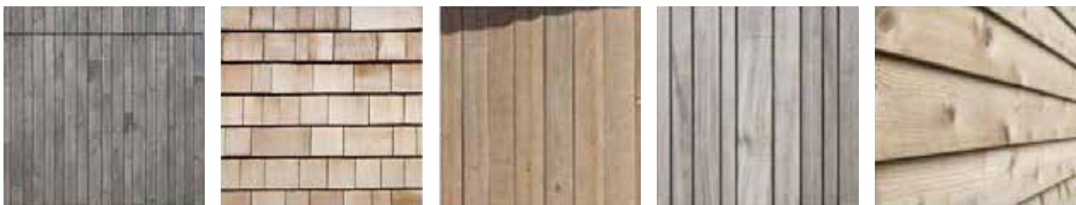
Gevel hout (natuurlijke kleur niet geveerd)
