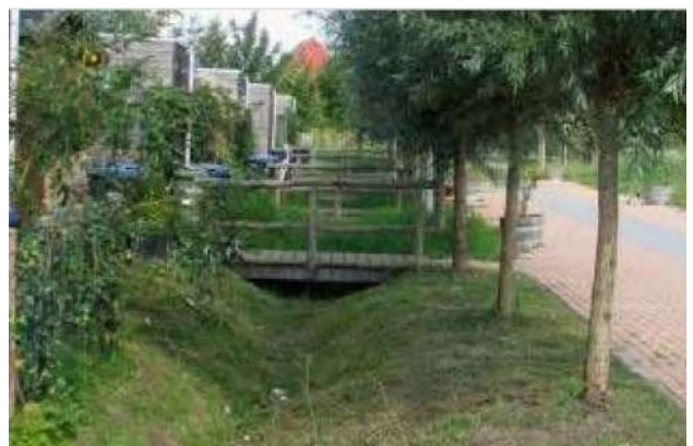
Woningen bereikbaar met bruggetje
