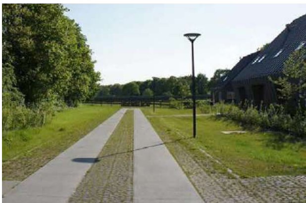
Karrenspoor met betonplaten
