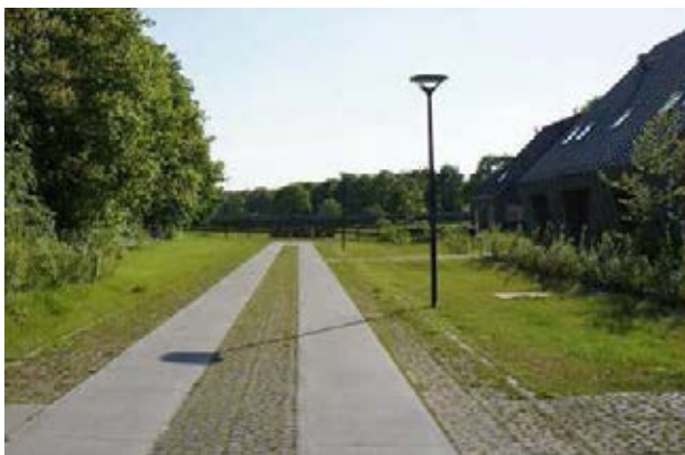
Karrenspoor met betonplaten
