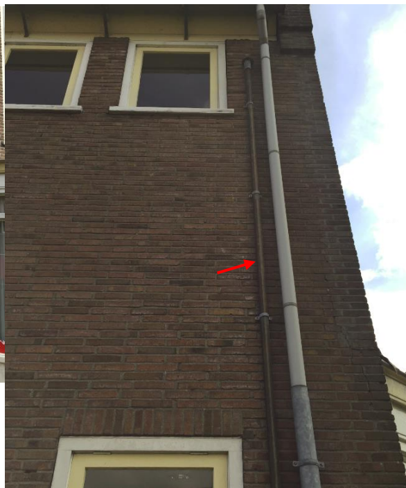
Afbeelding 5: ontuchttingspijp westzijde (detail)
