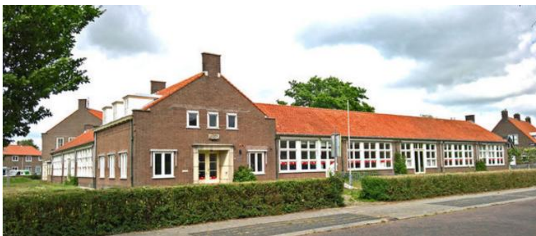
Afbeelding 3 Voormalige MAVO schoolgebouw
