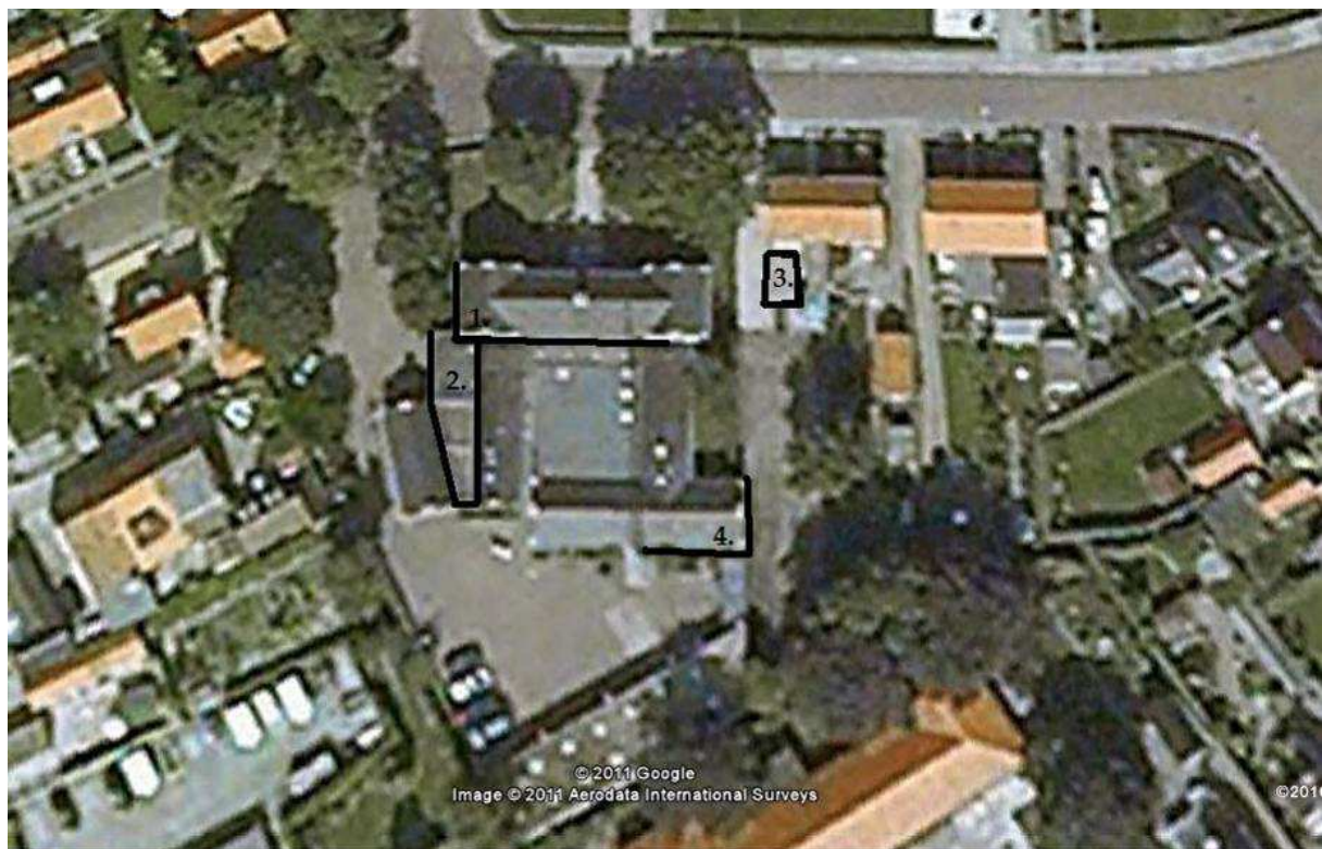
Figuur 9. Het plangebied met bijzondere locaties. Toelichting in de tekst onder 3.3 en 3.5 (Google Earth).
