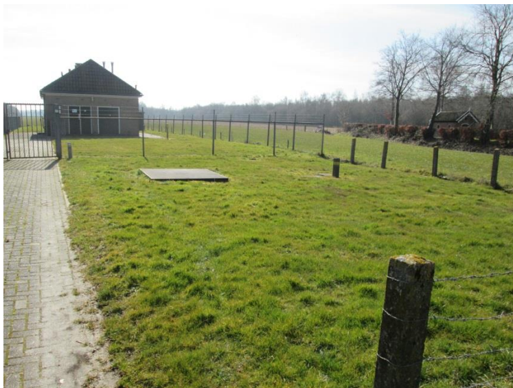
Foto 1. Zicht op het GOS vanaf de Pepergaweg.
