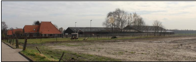
Figuur 15 Het erf vanaf de Bovenweg
