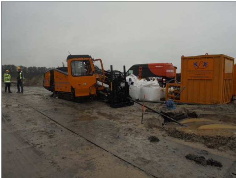
Figuur 3-3: Booropstelling ten behoeve van een gestuurde boring.
