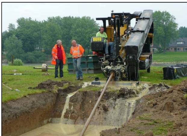
Afbeelding 3: Impressie gestuurde boring
