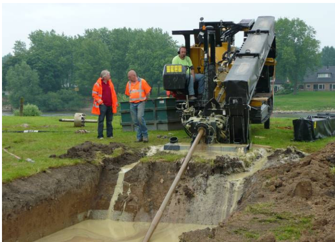
Figuur 2 Booropstelling ten behoeve van een gestuurde boring
