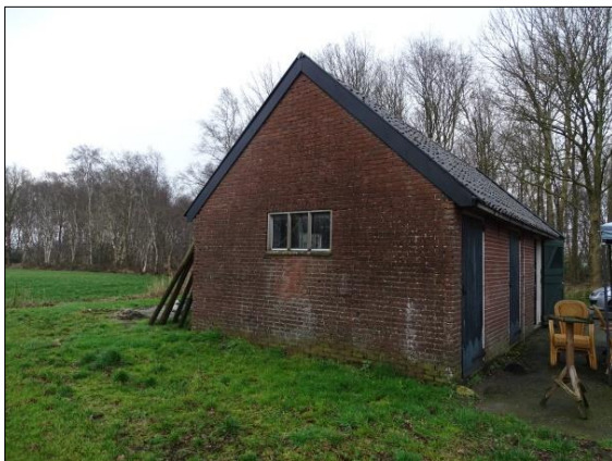
Figuur 1. Schuurtje in het plangebied met ruimte tussen de windveer en muur
