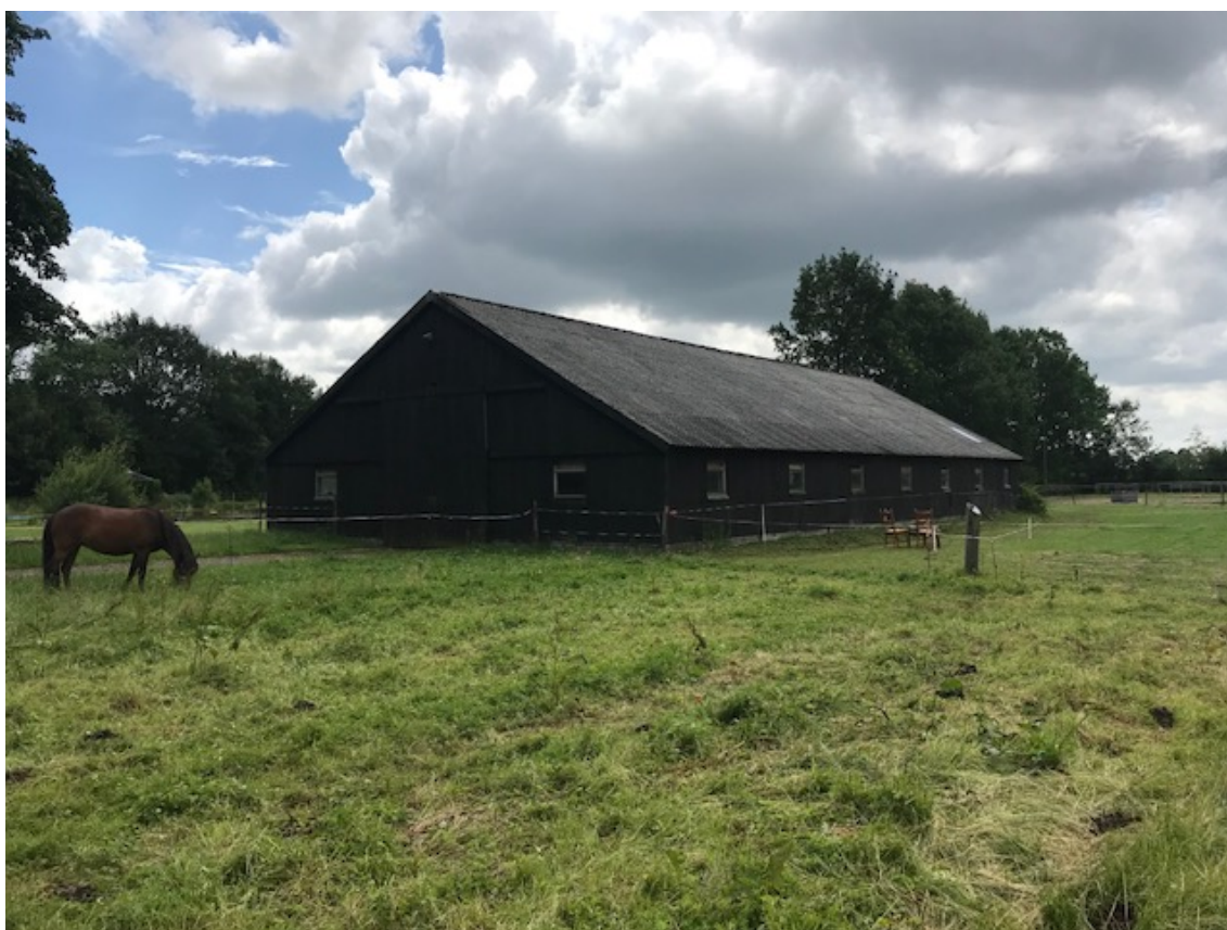
Figuur 2.1 Impressies bestaande schuur
