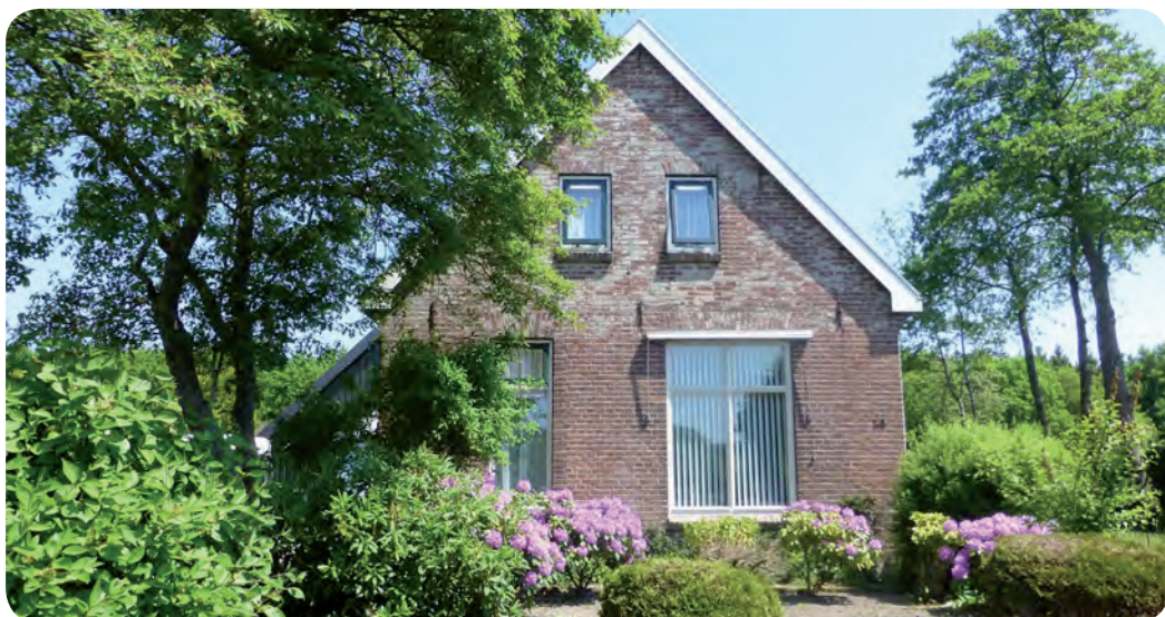
De woningen zijn opgetrokken in bruinrode baksteen, hebben een zadeldak met krimp en zijn gedekt met rode Friese pannen.
