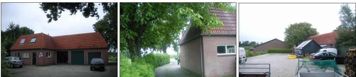
Figuur 5. Voor-, zij en achterzijde van de bedrijfsbebouwing
