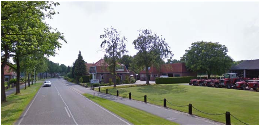
Figuur 4. Zicht op plangebied (Google Streetview, 2010)
