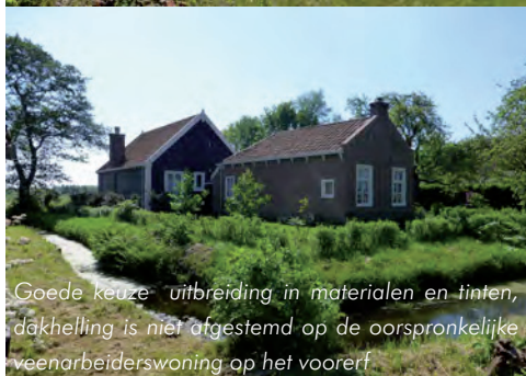
Uitbreiding in dezelfde dakhelling als de oorspronkelijke veenarbeiderswoning, goede keuze van materialen in gedekte tinten
