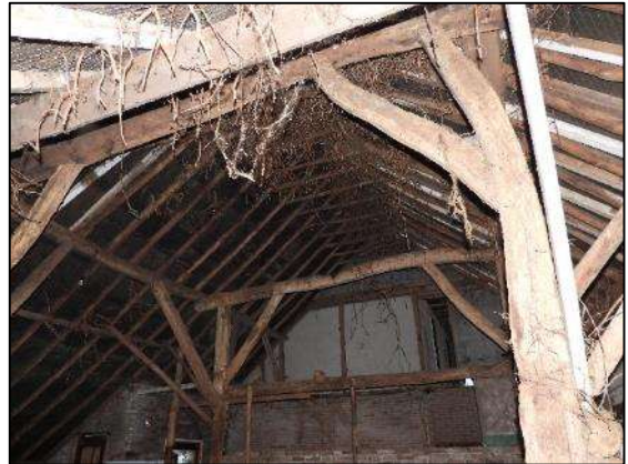
Afbeelding 1.8. Dak van schuur aan woning.
