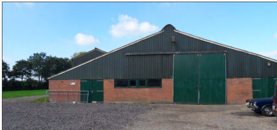
Figuur 6. Voorzijde voormalige ligboxenstal
