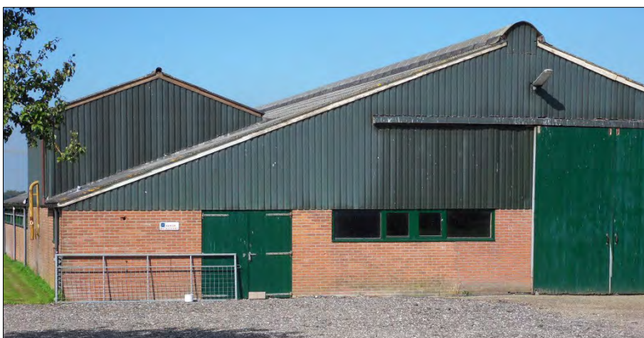
Figuur 2. Gevel van de te verbouwen stal
