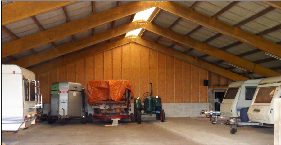
Figuur 7. Binnenzijde voormalige ligboxenstal
