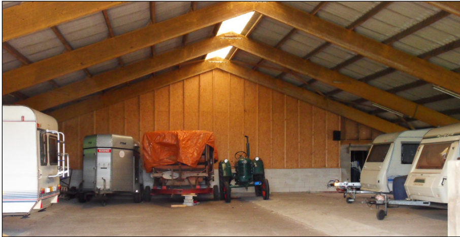
Figuur 7. Binnenzijde voormalige ligboxenstal
