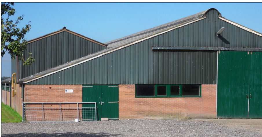
Figuur 2. Gevel van de te verbouwen stal
